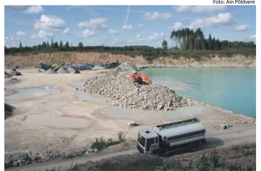
Ekskavaator tõstab vee all asuvat dolokivi karjääri põhjale veekogu serva nõrguma. Tagaplaanil töötab purustus-sõelumiskompleks, mis valmistab killustikku.
